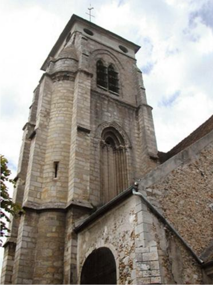
Le clocher de Longjumeau, objet des travaux de 1744.
